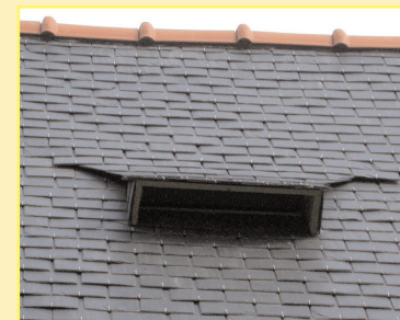
Nichoirs artificiels et ouverture pour les chauves-souris dans une toiture
