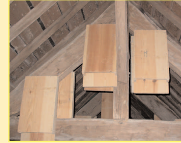
Nichoirs artificiels et ouverture pour les chauves-souris dans une toiture
