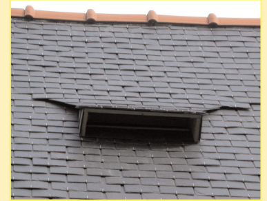
Nichoirs artificiels et ouverture pour les chauves-souris dans une toiture
